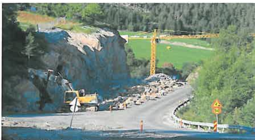
Fv. 755 mellom Leksvika og Vanvikan åpnet 28. november 2011
