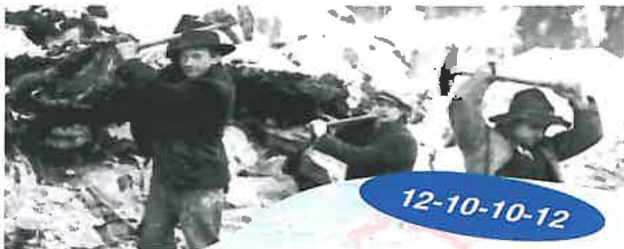
Byggestart på Fv 755 Vanvikan - Leksvik .
